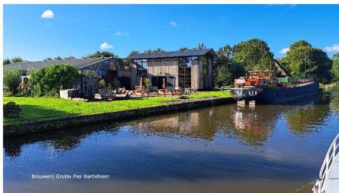
Brouwerij Grutte Pier Bartlehiem
